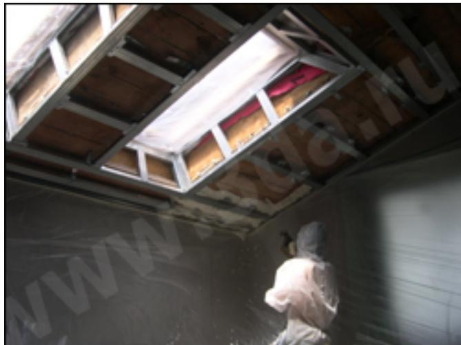
Неорганические теплоизоляционные материалы представлены в виде минеральной ваты (каменная и шлаковая), стекловолокна, алюминевой фольги, ячеистого бетона. Широкое применение при утеплении домов имеет минеральная вата. Этот материал не горит, обладает хорошей тепло и звукоизоляцией. Срок службы 5 – 10 лет при правильной эксплуатации. Основной недостаток этого материала его хрупкость, боязнь воды, пыль, осыпание.
